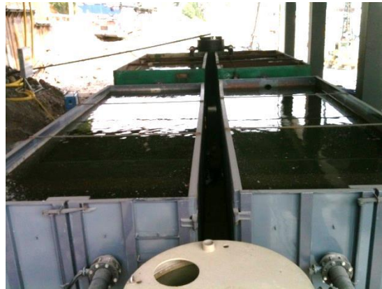
Abbildung 1: Anlage auf der Baustelle in Stockholm
