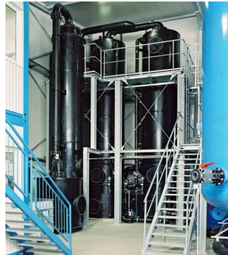
Abbildung 2: Grundwasserreinigungsanlage Altana
