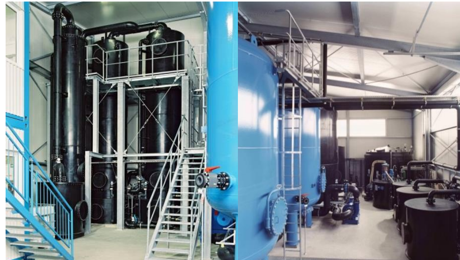
Grundwasserreinigungsanlage Altana
